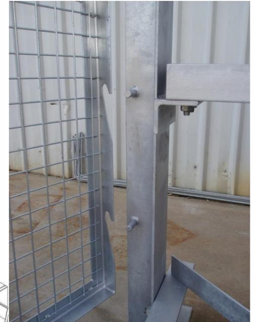
**D.I.L.O GUARD IS DROPPED DOWN INTO POSITION & SITS ON RODS WHICH ARE PART OF THE DUST COVER SUPPORT POST**
